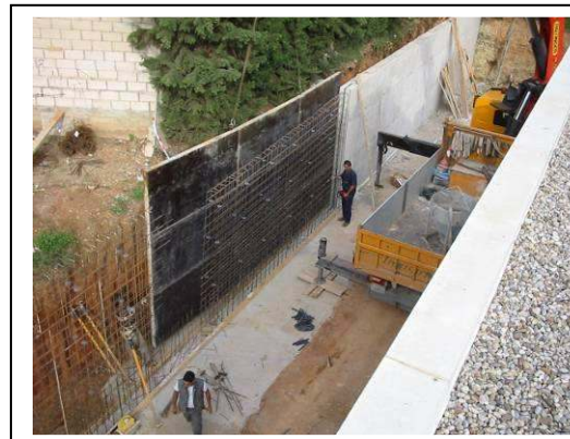
Mur de contenció de terres en l'accés al pàrquing
