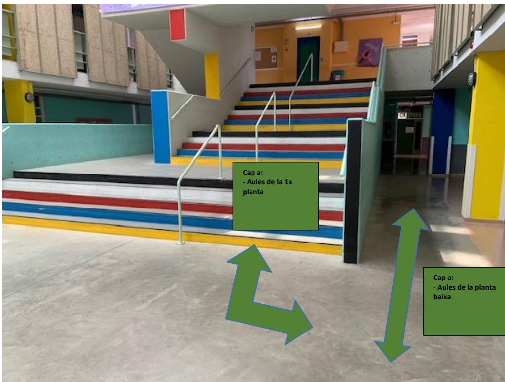
Foto 11 - Circuit marcat: accés aulari 1a planta
