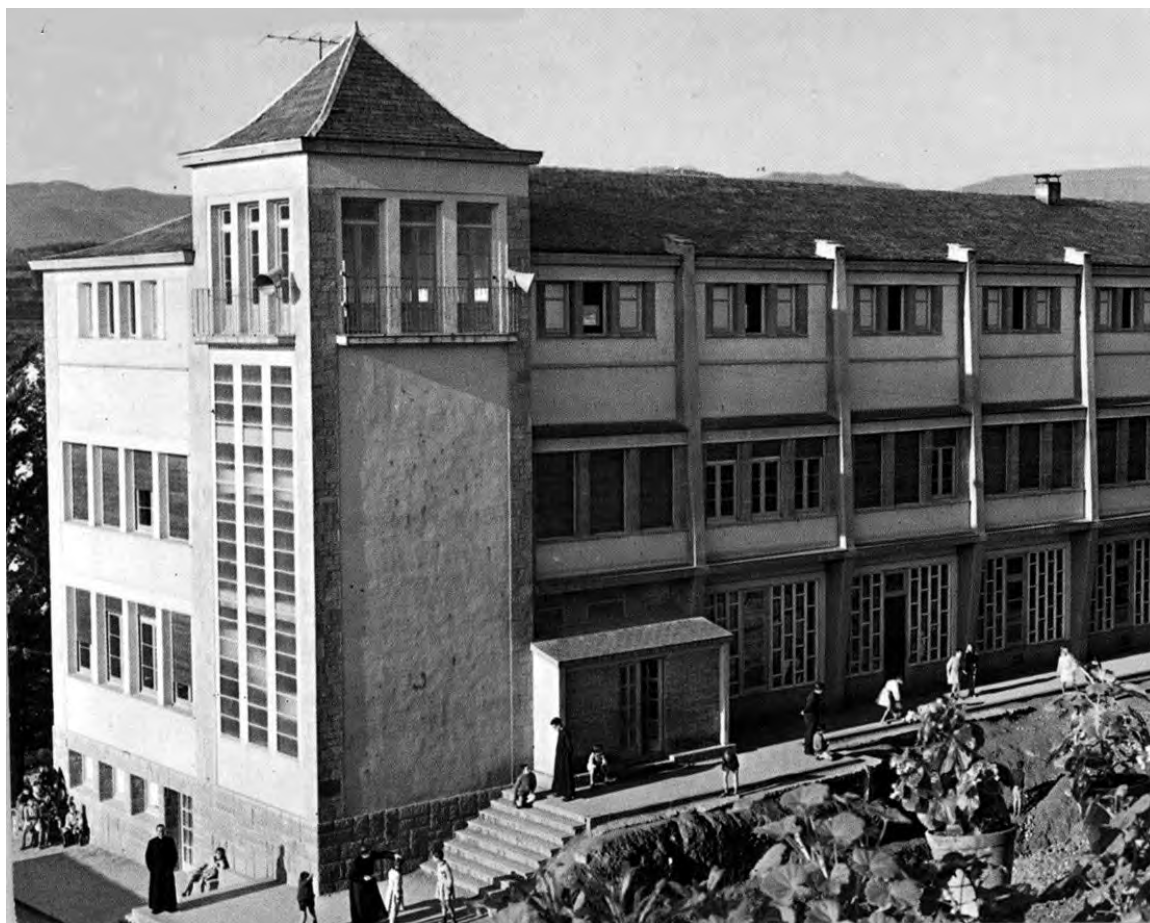
Imatge 9. Edifici del col·legi Pius XII. Extreta de: Servei Educatiu del Pallars
