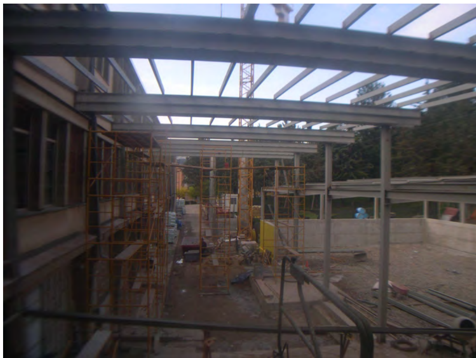
Imatge 21. Procés de remodelació i creació del gimnàs. Extreta de: Servei Educatiu del Pallars
