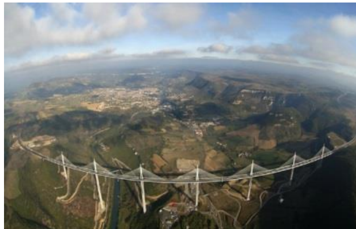
Figura 53: Viaducte de Millau
