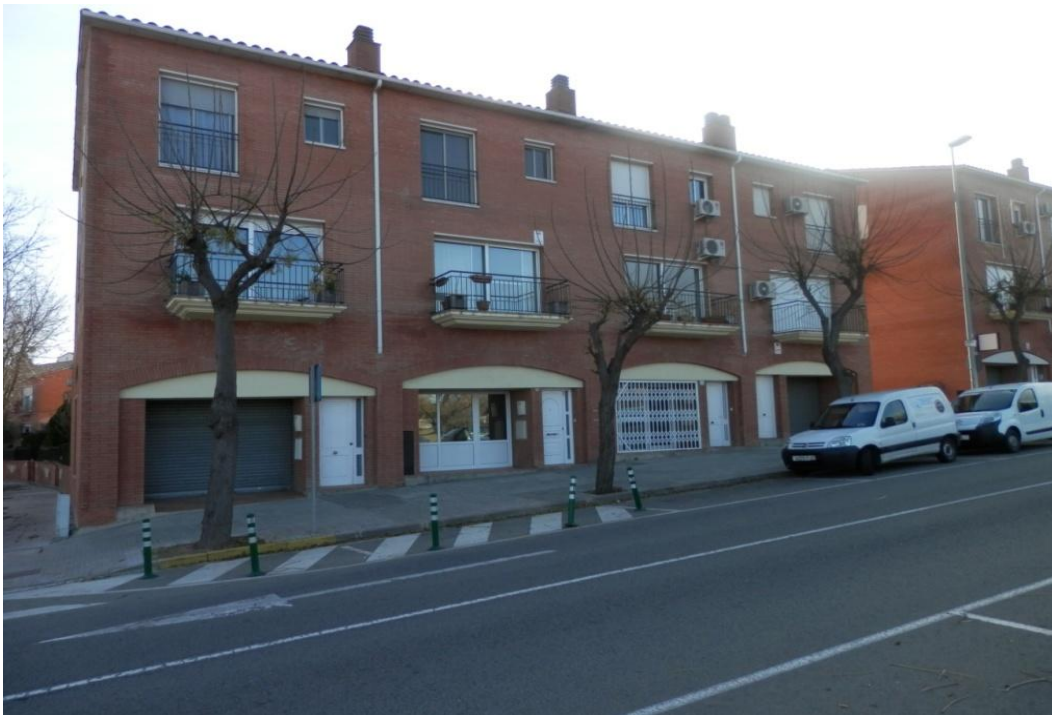
Figura 19: Vista cases adossades del local comercial. Font: Elaboració pròpia
