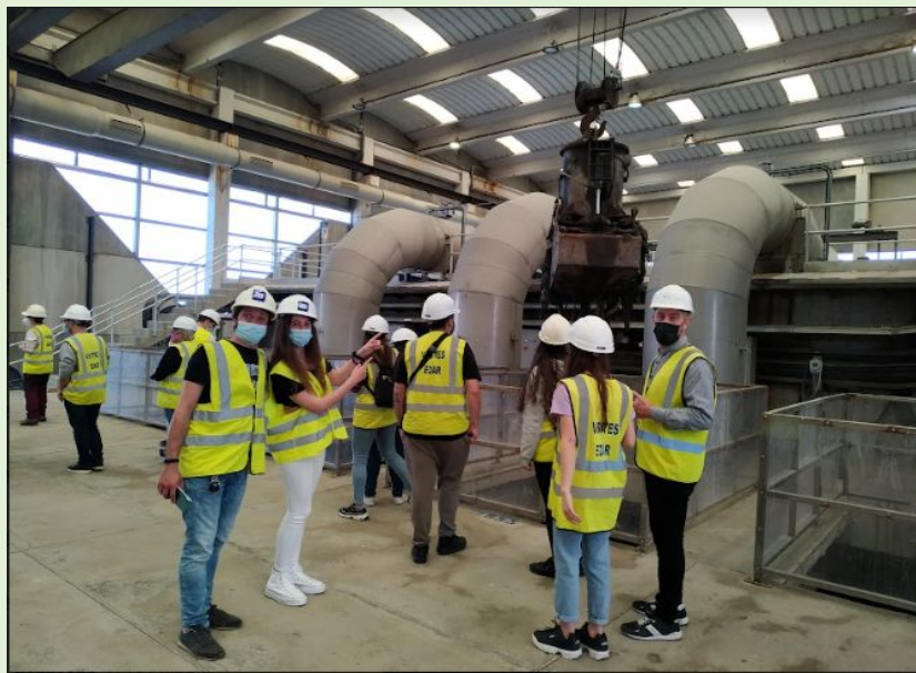
Depuradora d'aigües residuals del Prat
