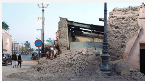
Les destrosses causades pels sismes
