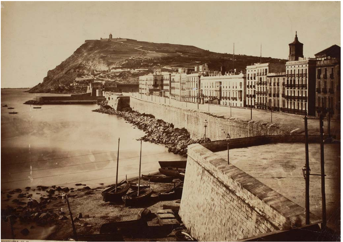
Muralla de mar, Barcelona, 1860
