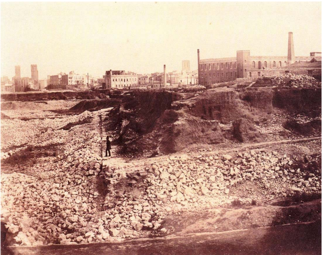
Enderroc de la muralla del carrer de Tallers, Barcelona, 1856. S'hi pot veure com dins de la ciutat hi havia nombroses fàbriques.
