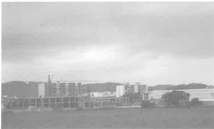
82. L'Institut de F.P., en construcció
