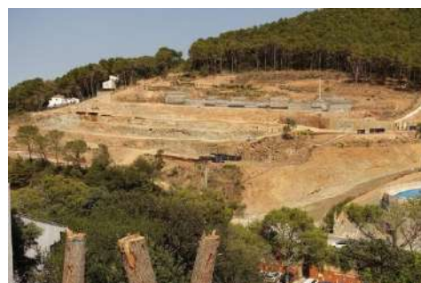
17. Vista de les obres als Jardins de Sa Riera Living.
