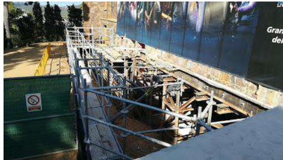
50. Obres subterrànies sota el castell.
