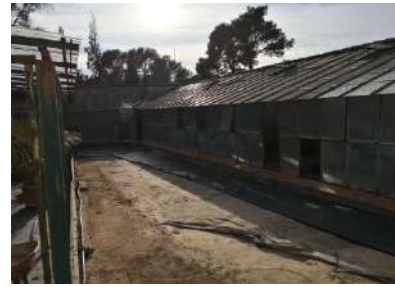
28. Hivernacles que es pretenen substituir per un edifici.
