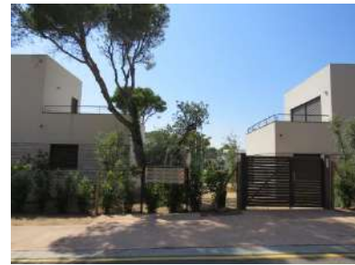
32. Peça que queda al mig, ja executada.
