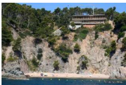
23. Vista de la cala del Golfet durant la construcció del xalet.
