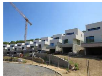
31. Peça que queda més lluny, en execució.
