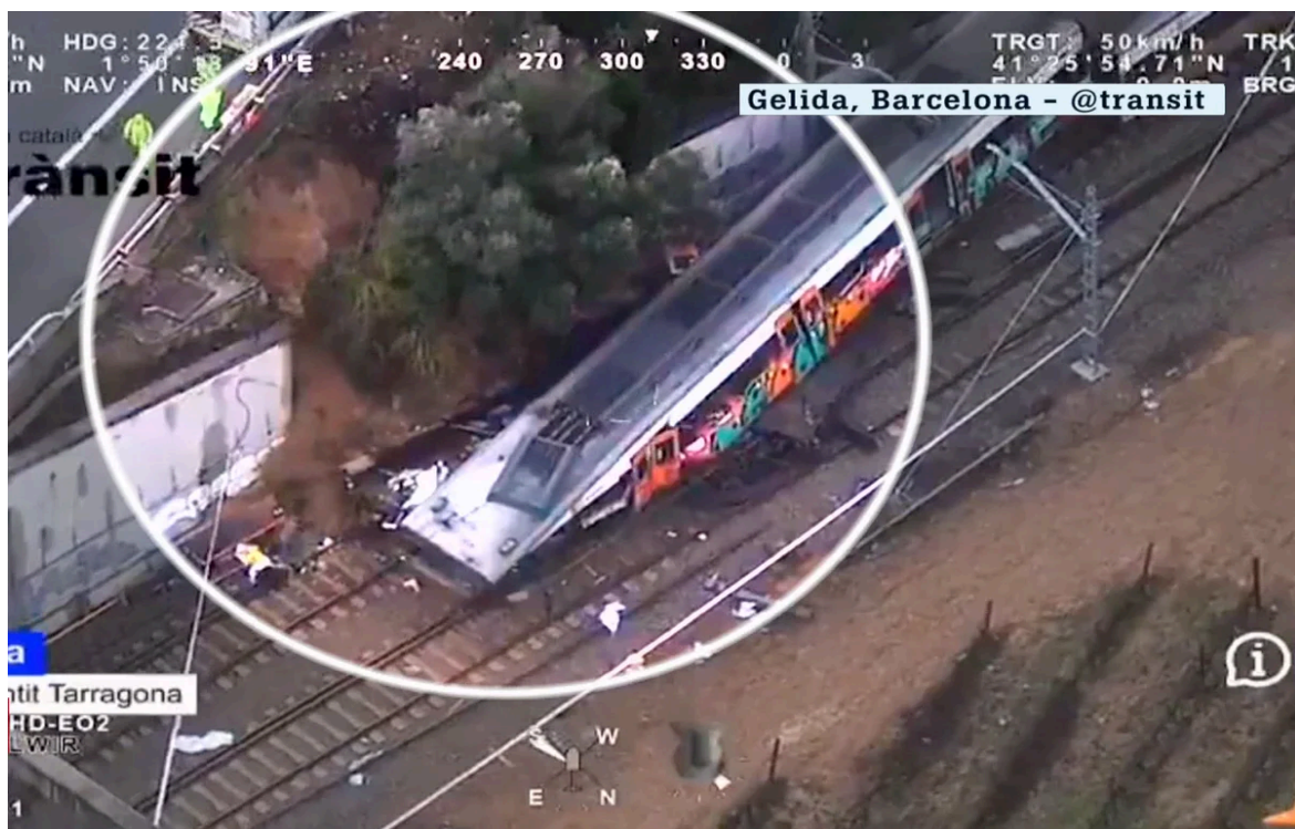
Accident d'un tren Rodalies per caiguda d'un mur
