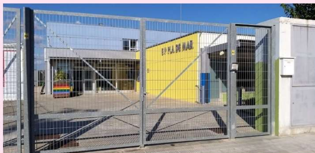
1 C/ DELS OCELLS (entrada principal)
