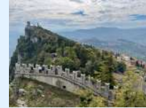
Les tres torres Guaita, Cesta i Montale
