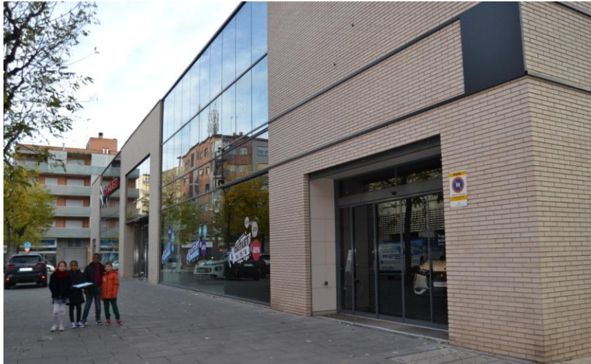
Façana del concessionari de cotxes.
