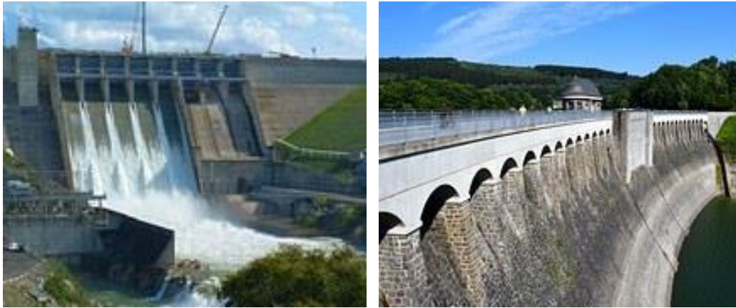
Fig. 3.8. Instal·lacions hidràuliques. Font: https://goo.gl/KWIR2v i https://goo.gl/mXkMOs
