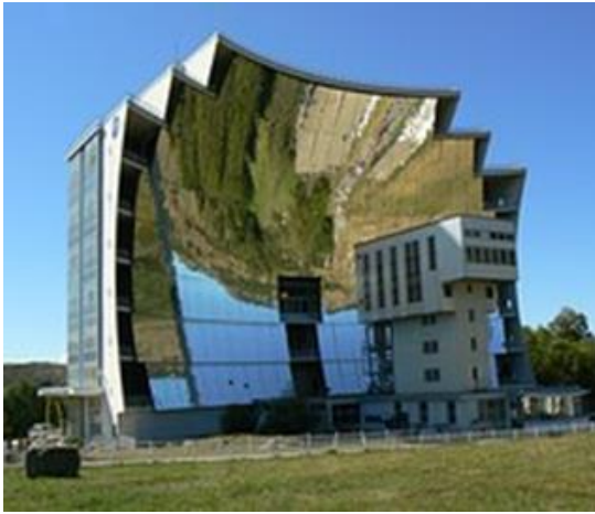
Fig. 3.4 Central solar tèrmica de captadors parabòlica; Odeillo, França
