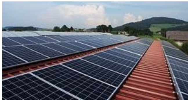
Fig. 3.6 Instal·lació de panells fotovoltaics. Font: https://goo.gl/5zr3Pa
